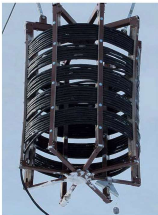
Рис. 6. Общий вид конструкции ЧЗУ
